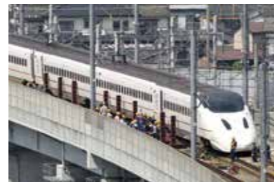
復旧作業が続く脱線した九州新幹線
