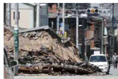
倒壊して道をふさいだ家屋 熊本市中央区
