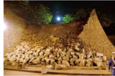
地震で崩れた熊本城二の丸の石垣 4月14日
