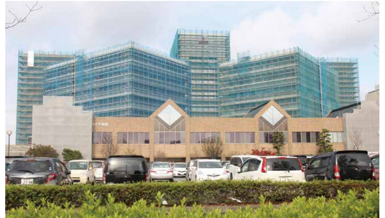
地震被害の復旧工事は平成28年4月16日から平成29年3月31日まで約1年の期間を要した
